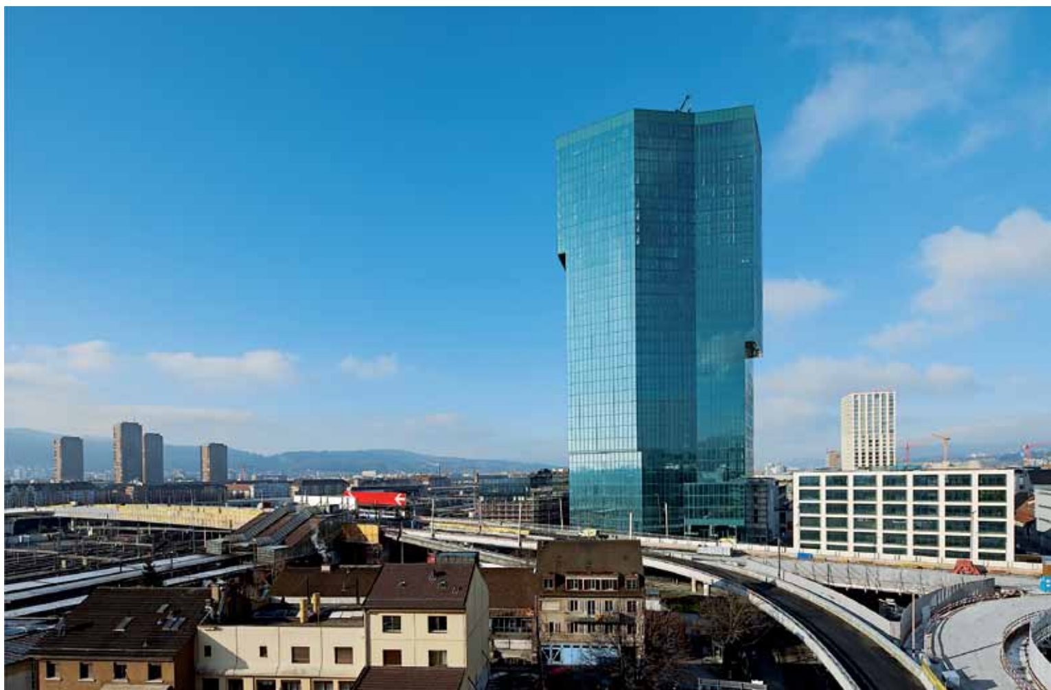
La Prime Tower à Zurich
